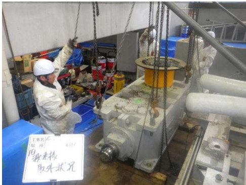
主減速機整備
