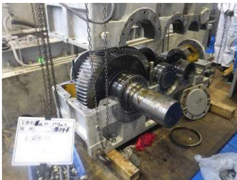
主減速機整備
