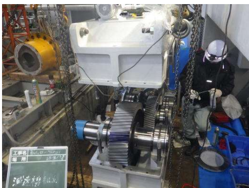
主減速機整備
