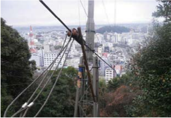
支曳索切り詰め工事
