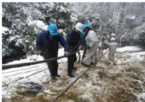
支曳索切り詰め工事
