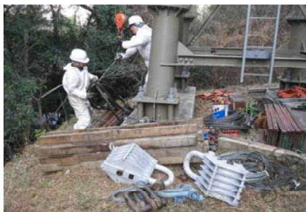
支曳索切り詰め工事
