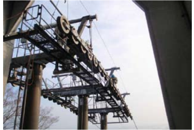
支柱索輪交換作業
