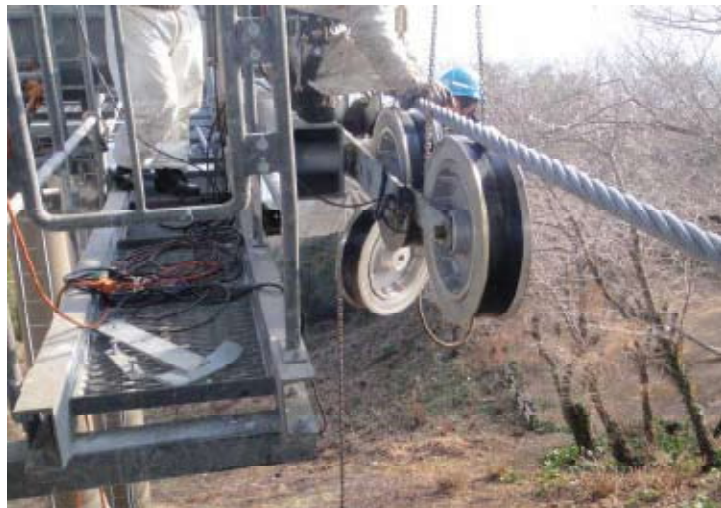
支柱索輪交換工事
